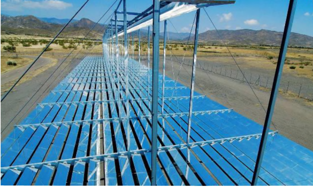
Şekil 2.7: Doğrusal fresnel yansıtıcı sistemleri (Url 4).
