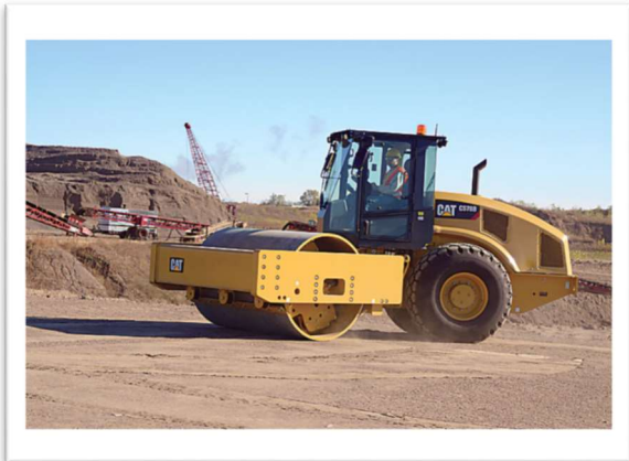
Resim 2.6. Zemin Sıkıştırma İşlemi
