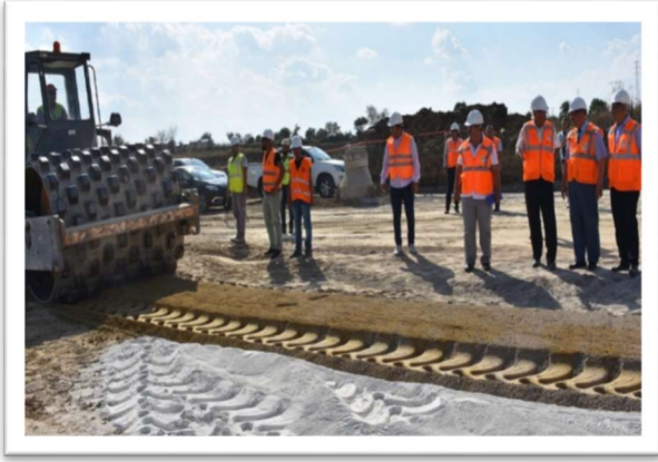
Resim 2.4. Zemin karıştırılması işlemi
