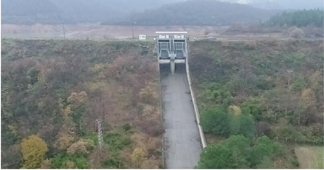
Şekil 5.10 : Gökçe barajı dolu savak genel görüntüsü.
