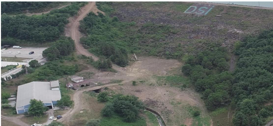
Şekil 5.11 : Gökçe barajı dip savak+vana odası genel görüntüsü.
