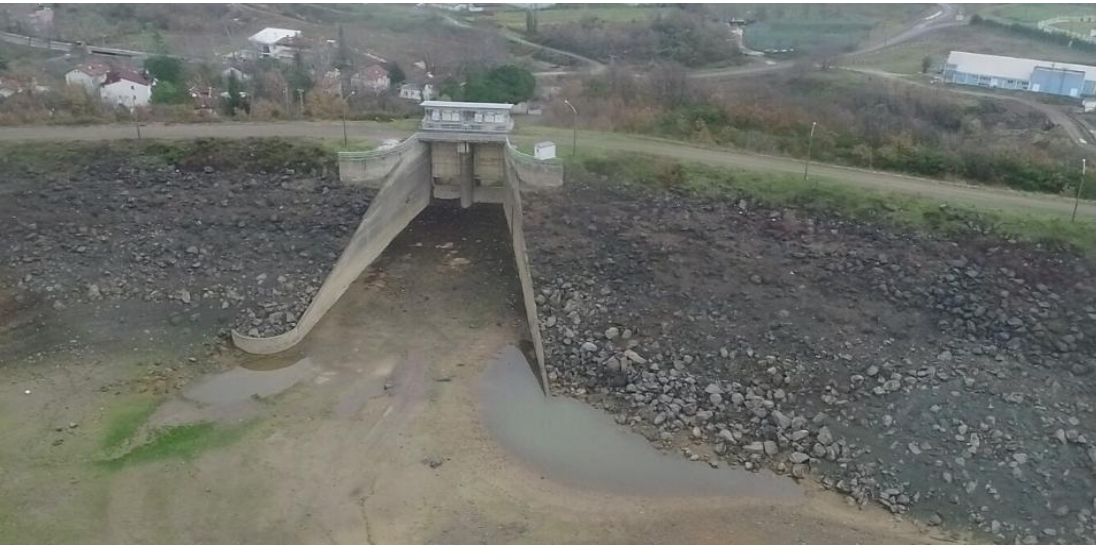
Şekil 5.9 : Gökçe barajı dolu savak genel görüntüsü.
