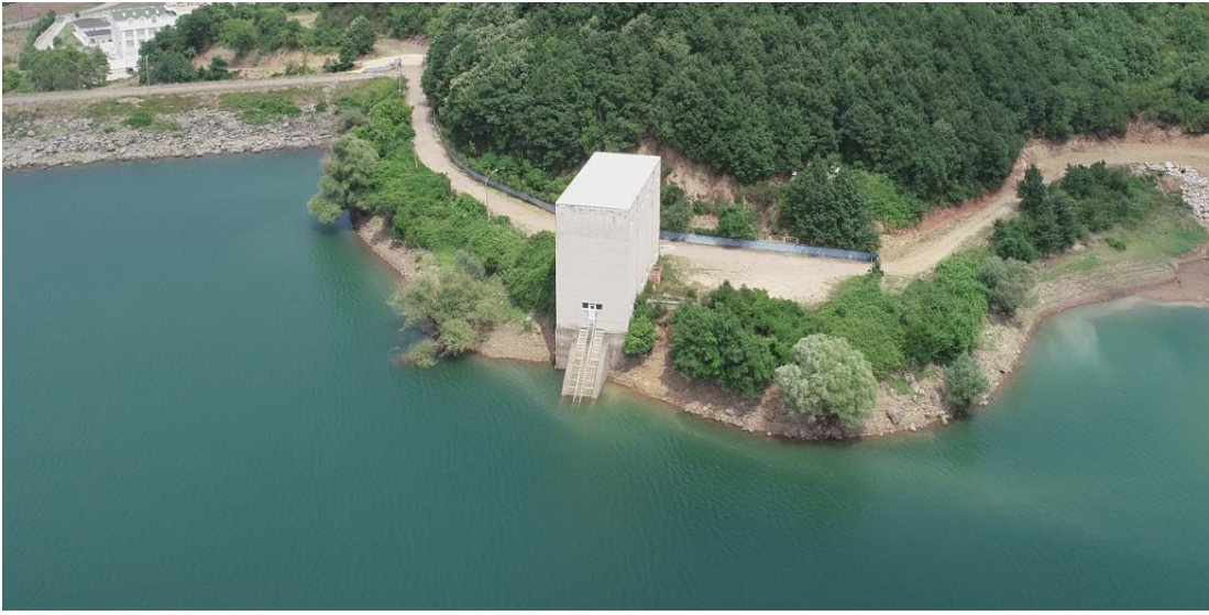
Şekil 5.12 : Gökçe barajı su alma yapısı genel görüntüsü.
