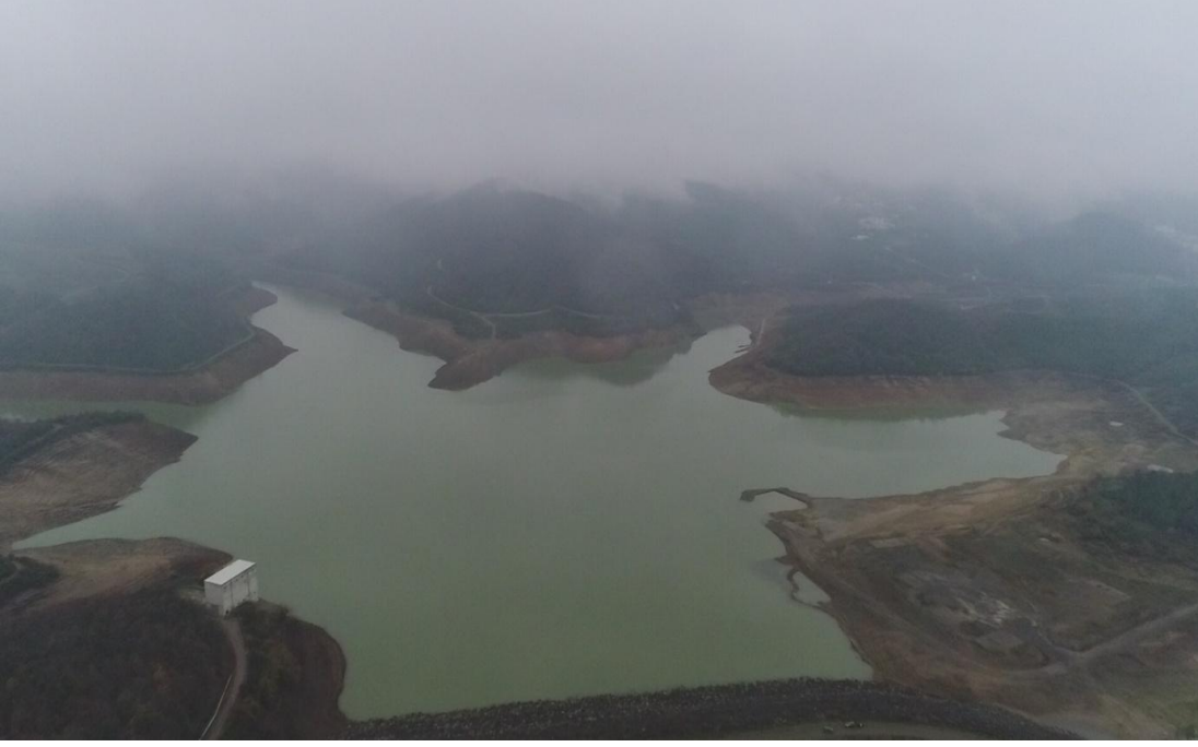
Şekil 5.8 : Gökçe barajı rezervuar ( baraj gölü ) genel görüntüsü.
