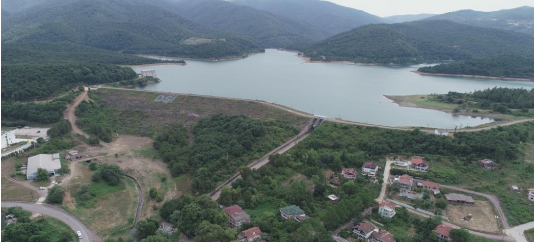
Şekil 5.5 : Gökçe barajı gövde genel görüntüsü.
