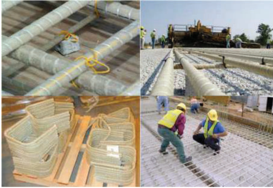
Şekil 1. Lif takviyeli polimer (FRP) donatı uygulama örnekleri (URL 1)
