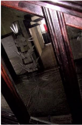
Camlı korkuluk detayı Merdivenin orta holden görünümü Baba dikmesi Şekil 4. İbrahim Cumalı Evi'nin iç mekân merdiven ayrıntısı (Hatice Uçar arşivinden)
