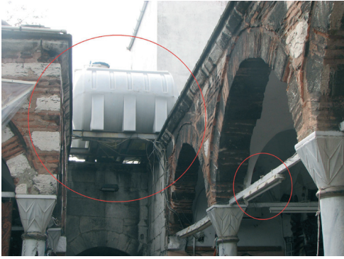
Şekil 42-43. Çorlulu Ali Paşa Camisi avlusundaki su deposu, aydınlatma elemanları, vb. eklentiler (İ.SAĞDIÇ; 2011)
