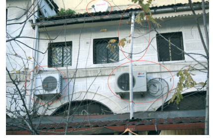
Şekil 22-23-24. Hoca Piri Camisi; Klima, baca, tente, tabela, sergileme elemanları ve çanak anten eklentileri (İ.SAĞDIÇ; 2011)
