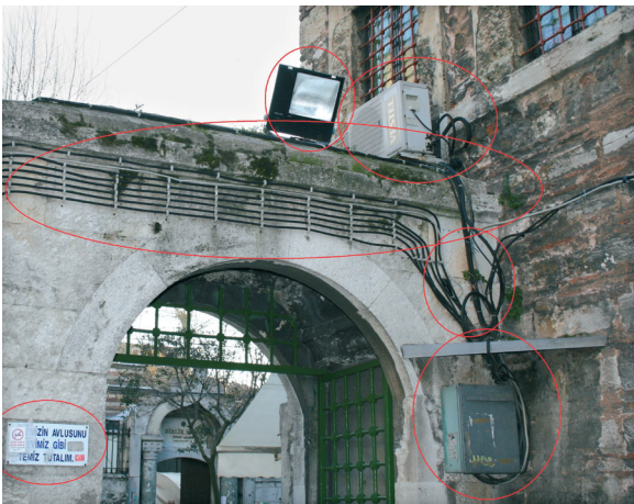
Şekil 55. Atik Ali Paşa Camisi, avlu kapısı ile birleşiminde bulunan tesisata ilişkin eklentiler
