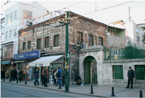
Şekil 52. Atik Ali Külliyesi'ne ait Muvakkithane - Sıbyan Mektebi, tabela, tente, klima, vb. eklentiler (İ.SAĞDİÇ; 2011)
