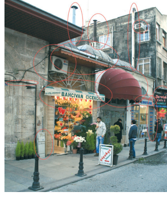
Şekil 62-63. Köprülü Mehmet Paşa Külliyesi dükkanlardaki tabela, klima ve tahliye bacası eklentileri (İ.SAĞDİCİ; 2011)
