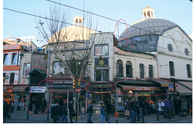
Sekil 58. Çemberlitaş Hamamı'nda anten, klima, tente ve giriş saçağı eklentileri (İ.SAĞDIC; 2011)
