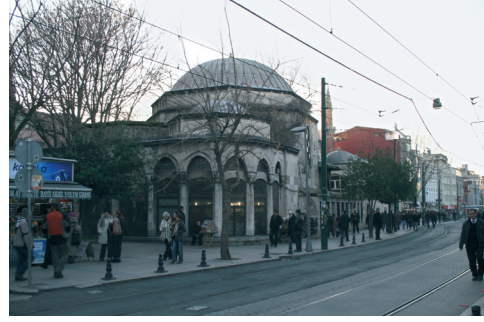
Şekil 31. Merzifonlu Kara Musta- fa paşa Kül- liyesi güney- doğu cephe- si (İ.SAĞDİÇ; 2011)
