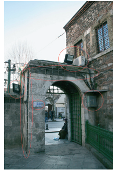
Şekil 53-54. Atik Ali Külliyesi'ne ait Muvakkithane - Sıbyan Mektebi, avlu giriş kapısı ile yapının bitiştigi noktada aydınlatma elemanları, anten, kablo ve klima eklentileri (İ.SAĞDİÇ; 2011)
