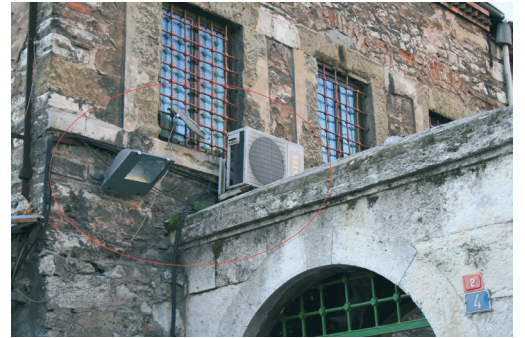
Şekil 53-54. Atik Ali Külliyesi'ne ait Muvakkithane - Sıbyan Mektebi, avlu giriş kapısı ile yapının bitiştigi noktada aydınlatma elemanları, anten, kablo ve klima eklentileri (İ.SAĞDİÇ; 2011)
