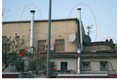
Şekil 22-23-24. Hoca Piri Camisi; Klima, baca, tente, tabela, sergileme elemanları ve çanak anten eklentileri (İ.SAĞDIÇ; 2011)
