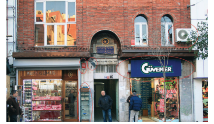
Şekil 51. Mimar Hayrettin Camisi'nin zemin katındaki dükkânlarda bulunan tabela, klima, vs. eklentiler (İ.SAĞDİÇ; 2011)
