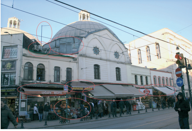
Sekil 57. Çemberlitaş Hamamı'nda anten, klima, tente ve giriş saçağı eklentileri (İ.SAĞDIC; 2011)
