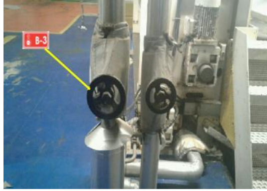
Resim 4.27. Püskürtme buhar giriş enerjisi kesme noktası
