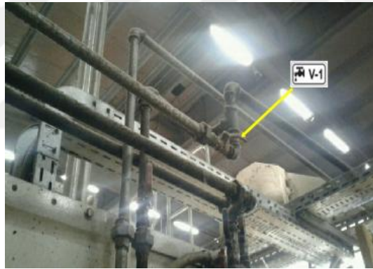
Resim 4.33. Oluklama basınçlı su enerjisi kesme noktası
