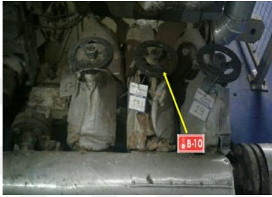
Resim 4.15. Ön ısıtıcı giriş buhar enerjisi (2) kesme noktası
