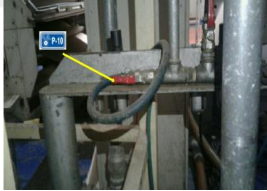
Resim 4.38. Tutkal ünitesi üst tava basınçlı hava enerjisi kesme noktası
