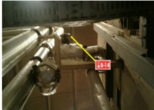
Resim 4.19. Ön ısıtıcı buhar dönüş enerjisi (3) kesme noktası
