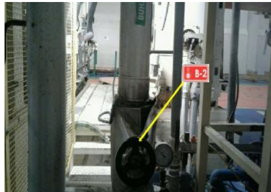
Resim 4.26. Ana buhar dönüş enerjisi kesme noktası
