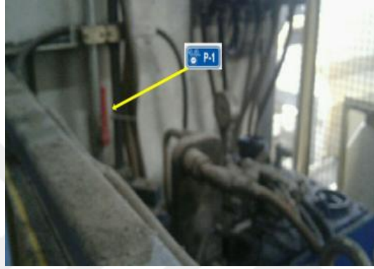
Resim 4.30. Oluklama ana giriş basınçlı hava enerjisi kesme noktası
