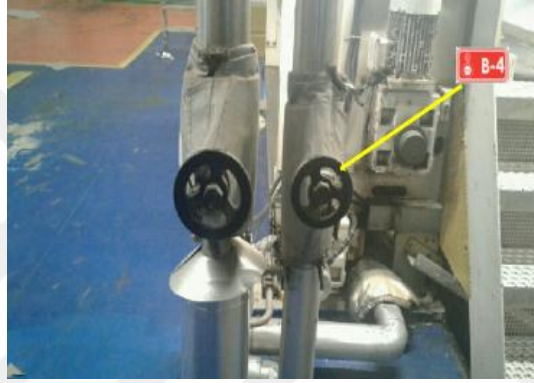
Resim 4.28. Püskürtme buhar çıkış enerjisi kesme noktası
