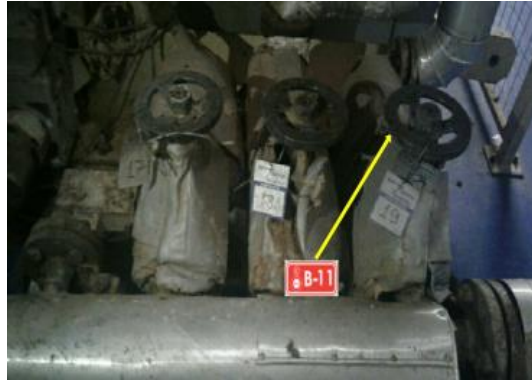
Resim 4.16. Ön ısıtıcı giriş buhar enerjisi (3) kesme noktası
