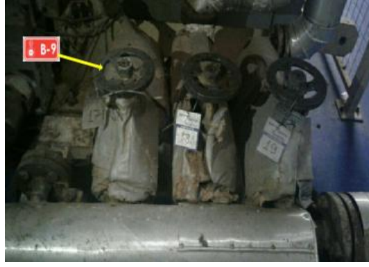
Resim 4.14. Ön ısıtıcı giriş buhar enerjisi (1) kesme noktası
