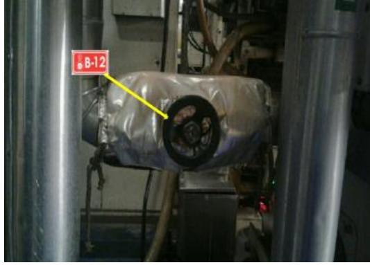
Resim 4.17. Ön ısıtıcı buhar dönüş enerjisi (1) kesme noktası
