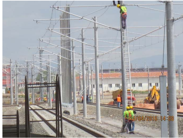
Resim 3.22. Katener hattı yapım işleri
