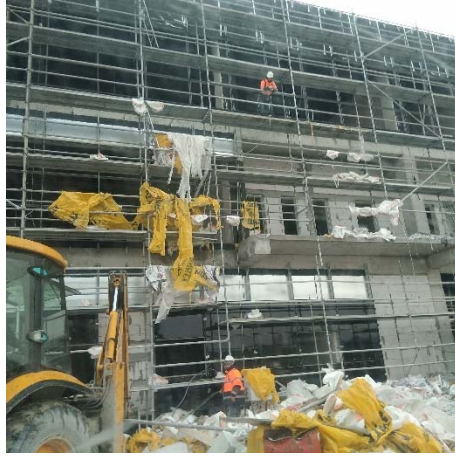
Resim 3.42. Dış cephe işleri 2
