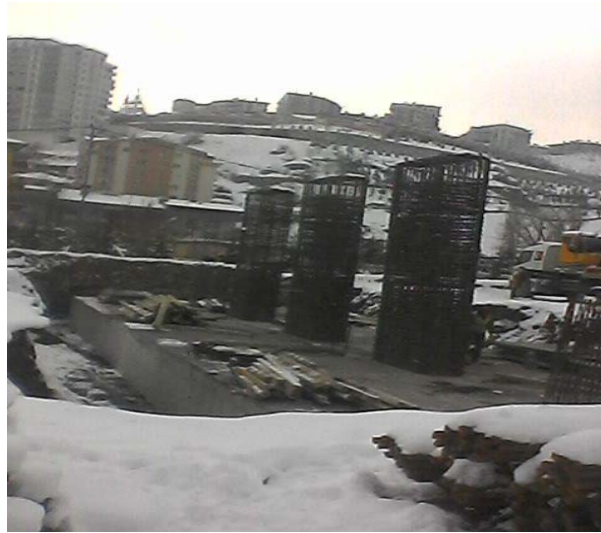
Resim 3.28. Demir, kalıp , beton işleri
