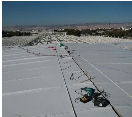
Resim 3.41. Dış cephe işleri
