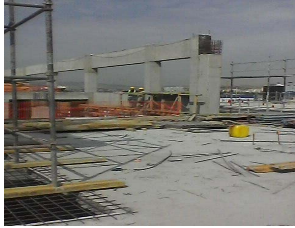
Resim 3.30. Demir, kalıp , beton işleri 3
