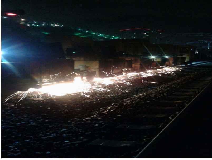
Resim 3.17 Mobil ray taşlama
