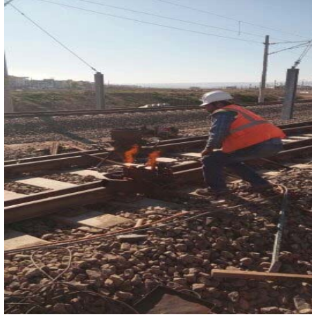
Resim 3.15. Amüinotermit ray kaynağı
