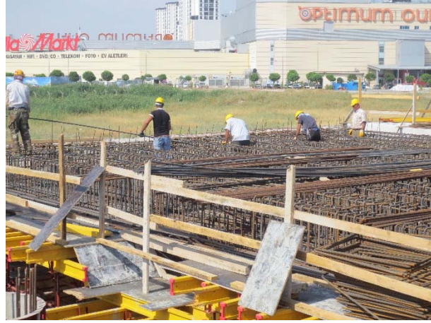
Resim 3.29. Demir, kalıp , beton işleri 2
