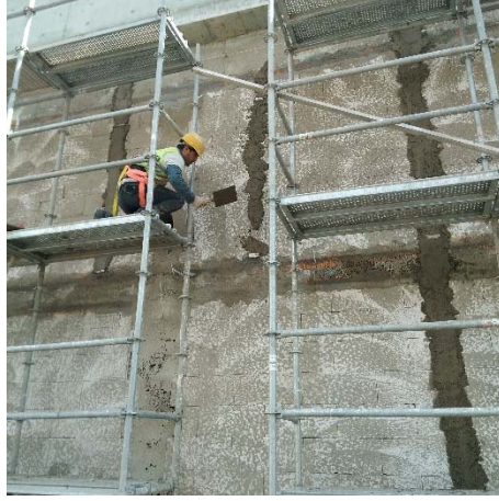
Resim 3.43. Dış cephe işleri 3
