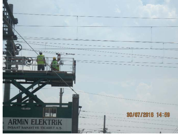
Resim 3.23. Kataner hattı yapım işleri 2
