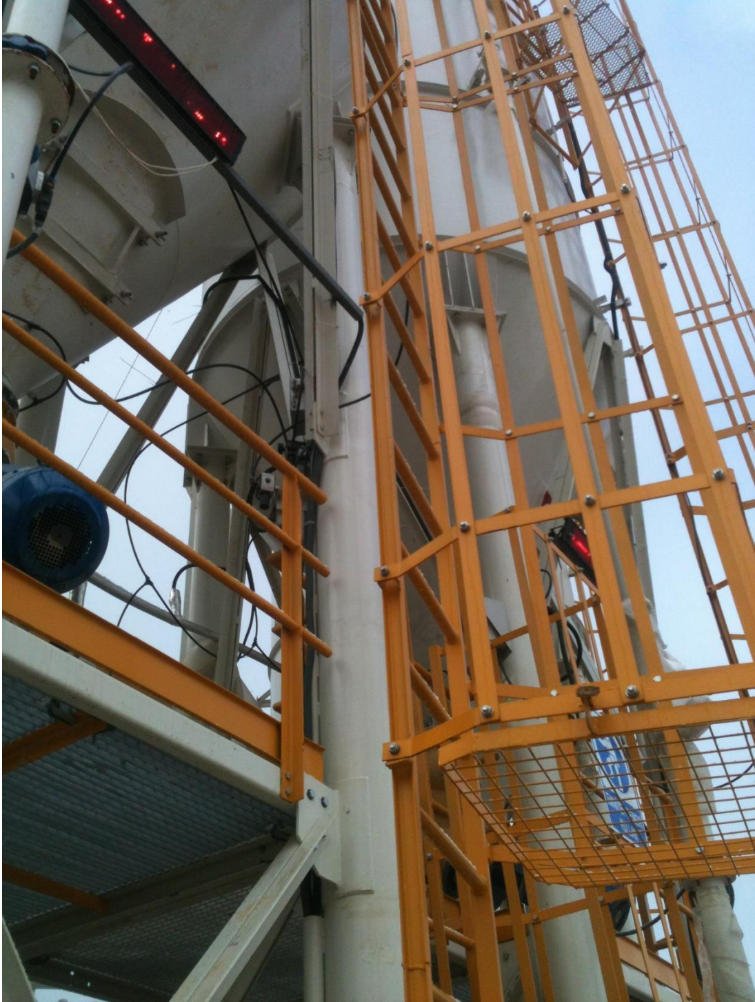
Şekil 5.14 : imento silolarına erişim için kullanılan gemici merdiven ağız izinsiz girişlere karşı kapatılması.
