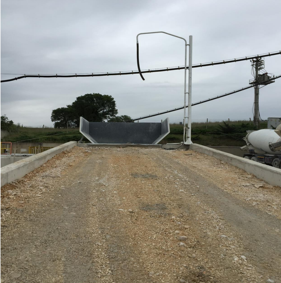
Şekil 4.17 : Transmikserlerin dolum sonrası beton artıklarının temizlendiđi alan.
