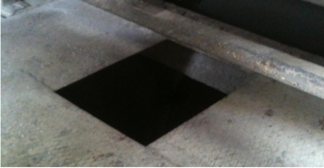
Şekil 4.11 : Santral mikser bölgesi geçiş alanında bulunan açıklık.
