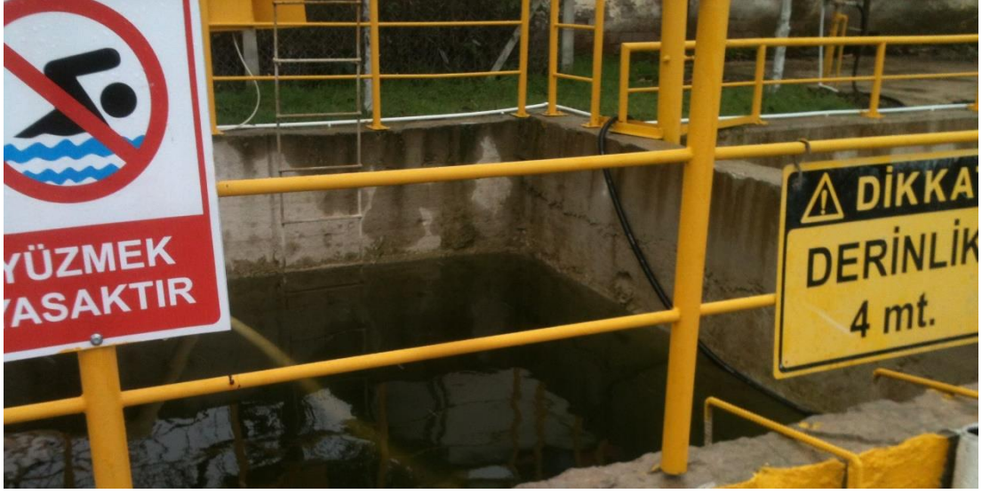
Şekil 5.12 : Karma suyu ve geri dönüşüm havuzları bölgesinde uyarı işaretleri.
