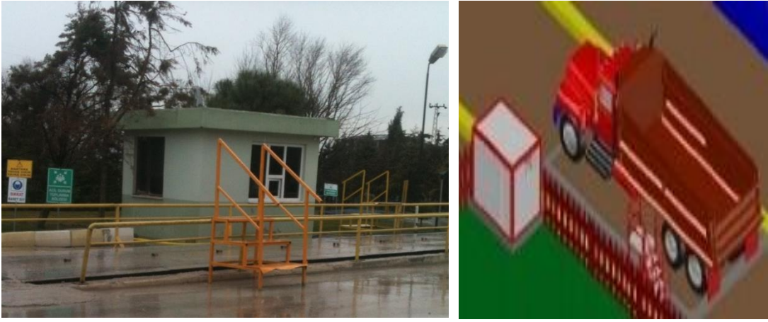
Şekil 5.17 : Agregta kamyonundan numune alma için kullanılacak platform.
