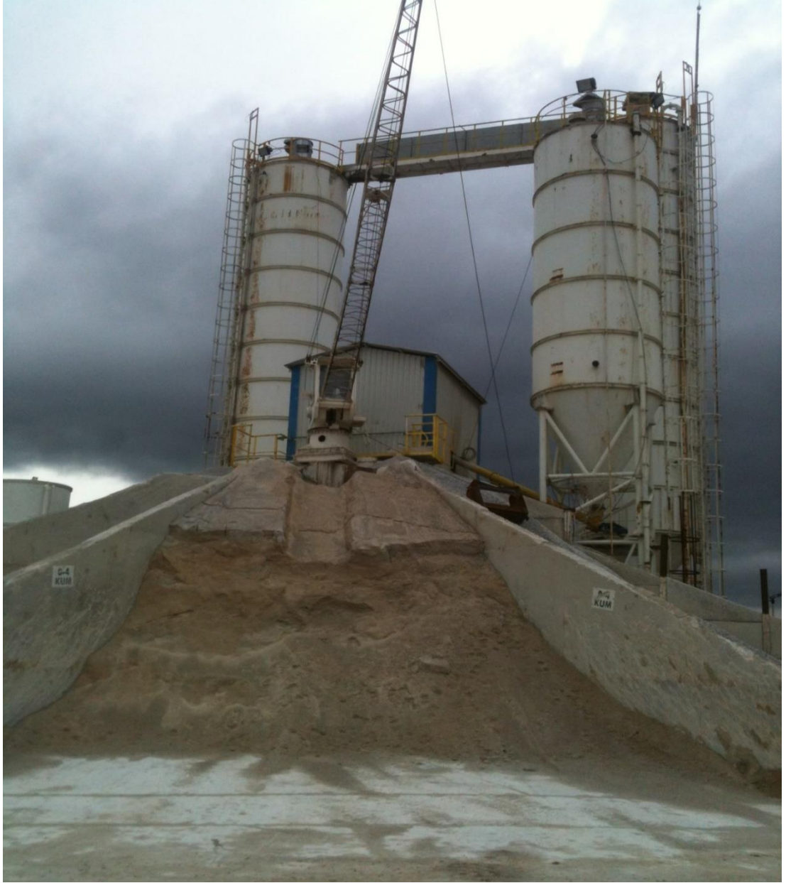
Şekil 3.4 : Yıldız tip skreyperli hazır beton santrali.
