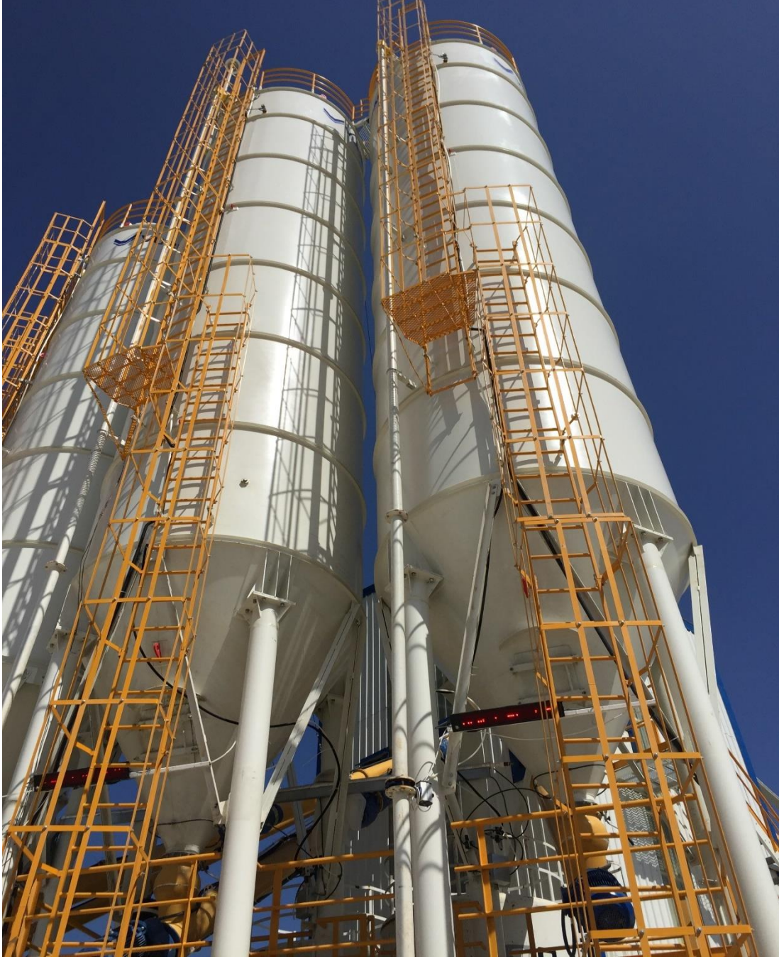
Şekil 5.16 : Çimento silolarına çıkışta kullanılan gemici merdiveninde ara dinlenme platformu.
