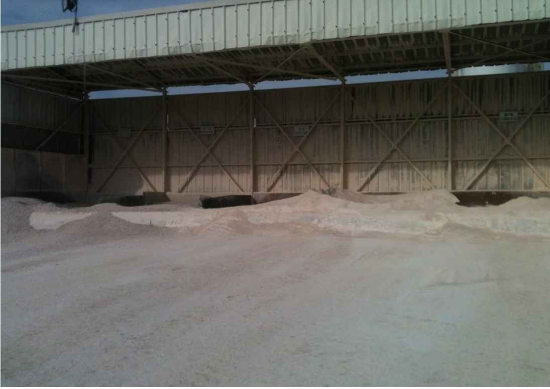
Şekil 3.5 : Bunker tip hazır beton santrali bunker dolum ağızı.
