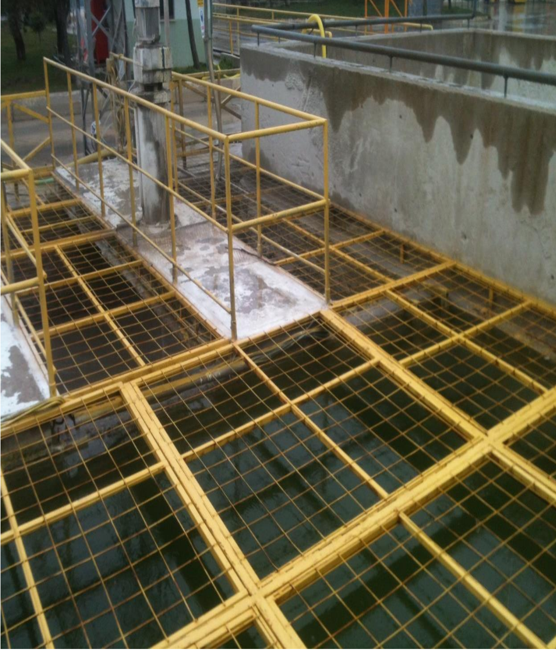
Şekil 5.11 : Karma suyu ve geri dönüşüm havuz üstlerinin ızgara platform ile kapatılması.
